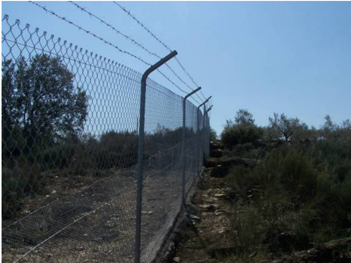
Figura 101 – Aspectos das obras para construção de um cercado de coelhos em Lagoaça.
