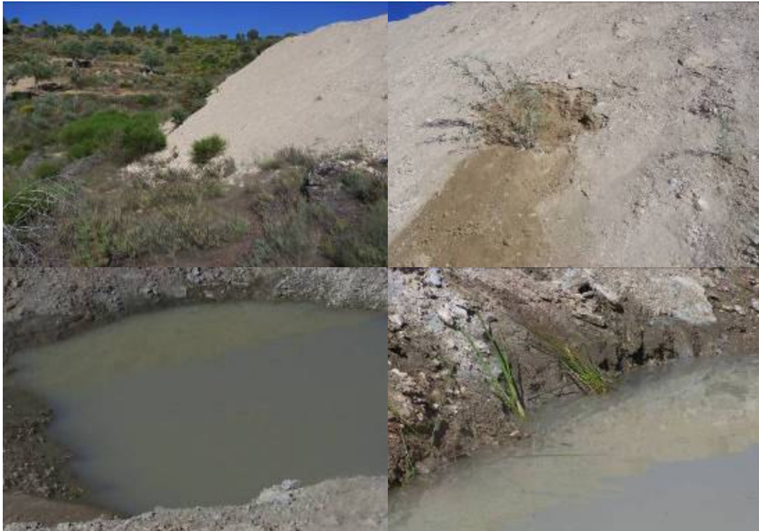
Figura 92 – Aspecto antes (esquerda) e após (direita) a renaturalização
