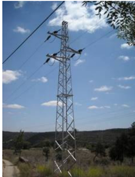
c) Isolamento de cabos e de arcos e mecanismo espanta pássaros em apoio metálico tipo galhardete
