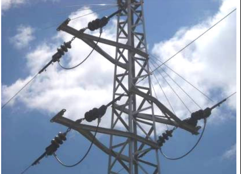
c) Isolamento de cabos e de arcos e mecanismo espanta pássaros em apoio metálico tipo galhardete
