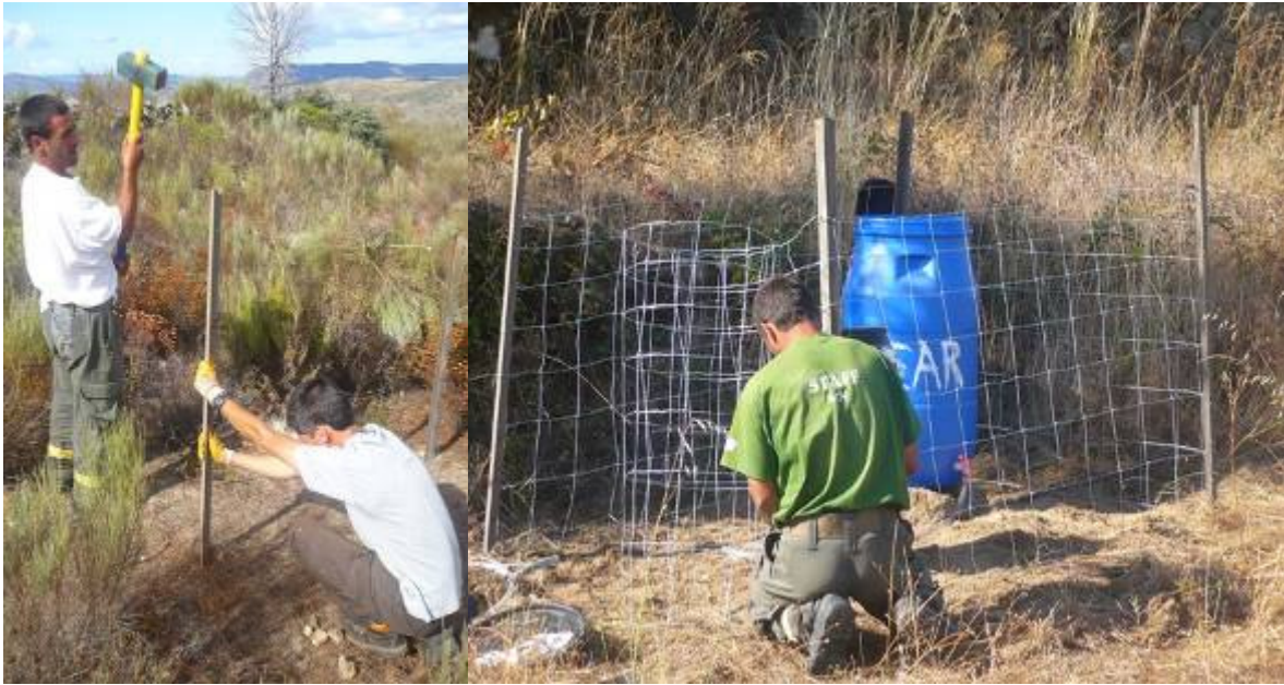
Figura 143 - Montagem da vedação .
