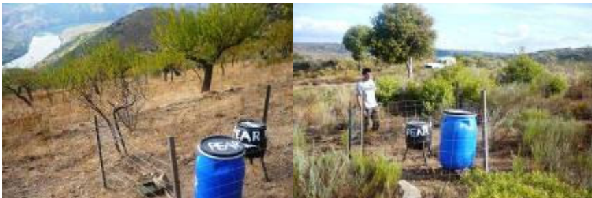
Figura 146 -Finalização da instalação.
