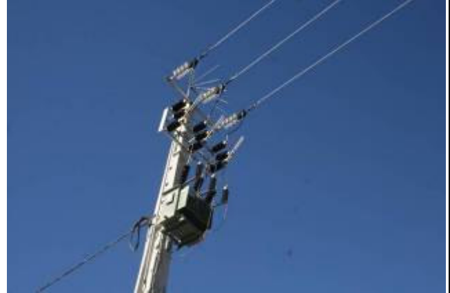
b) Isolamento de cabos na saída e colocação de mecanismo espanta pássaros num PT
