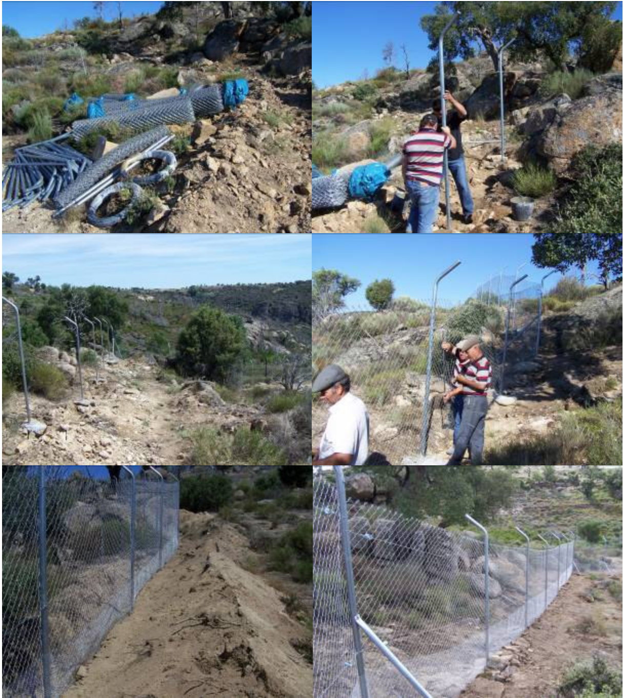
Figura 96- Etapas da construção do Cercado.
