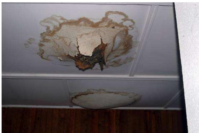
**Imagem 4. Casa pré-fabricada com detalhe do estado do tecto falso do edifício.**
