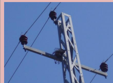
Poste de média tensão com apoios considerados perigosos para avifauna. Observa-se uma águia-d’asa-redonda morta por electrocussão no apoio. Fonte: www.erse.pt
