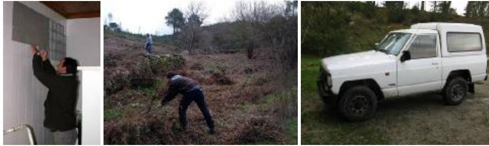
Imagens 4 a 6: Reparação de parede da clínica; corte de mato; viatura cedida pela EDP.
