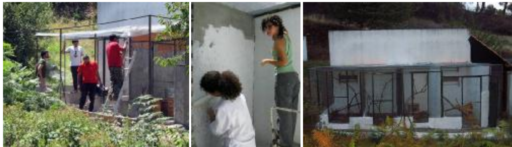
Imagens 1 a 3: Construção e aspecto final das 4 novas câmaras de muda de pequena dimensão (2x3m)
